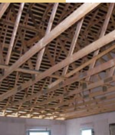
Charpente à fermette
