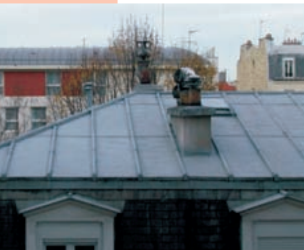
Couverture en feuilles de zinc
