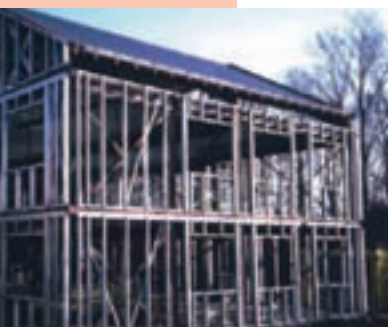
Structure en pan de fer
