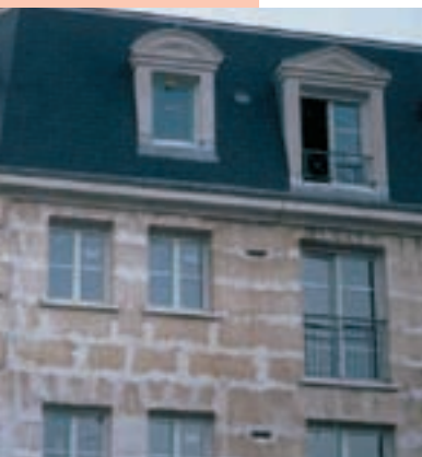
Montage au plâtre
