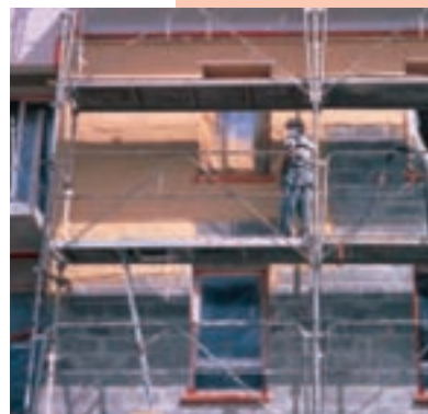
Chantier enduit monocouche
