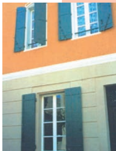
Modénature façade enduite
